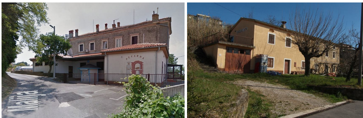
Slika 14, 15: stavba stare šole in gasilski dom.
